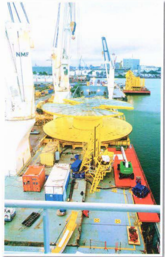
In Newcastle wartet das zuvor montierte Karussell auf die ebenso große Rohrleitung für das nigerianische Projekt Egina Oil Field.
